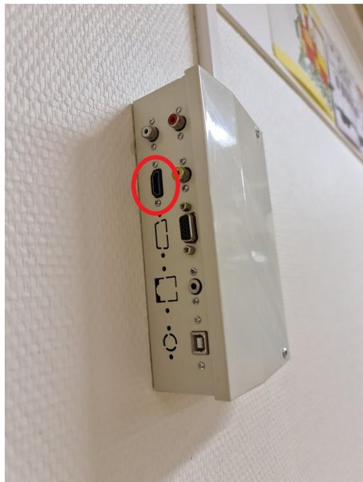
Lorsque le câble HDMI est relié entre le boîtier et l'ordinateur, la source bascule automatiquement pour projeter l'image de l'ordinateur via le câble. Si le basculement ne se fait pas de façon automatique, vous avez la possibilité de sélectionner la source via la télécommande ou le bouton du vidéoprojecteur.
